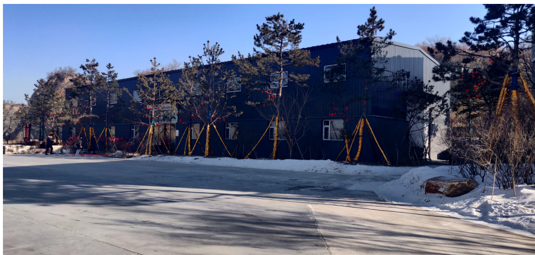
2022年1月现场情况
